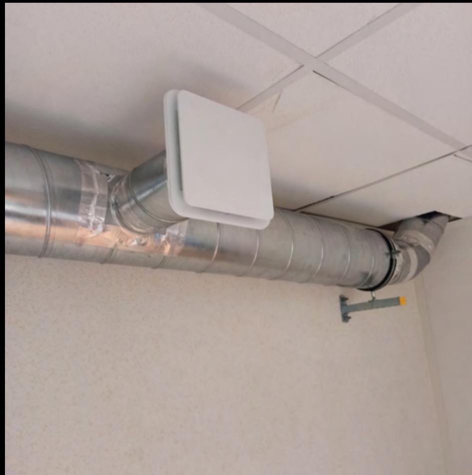
Bouches de soufflage dans les pièces exposées au radon
